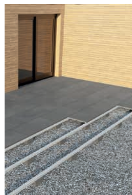
Verlegung auf Terrassen- Unterkonstruktion
