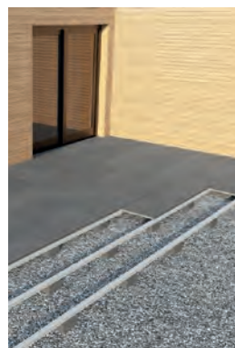
Polaganje na podkonstrukcijo terase
