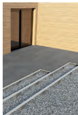
pokládka na nosnú konštrukciu
