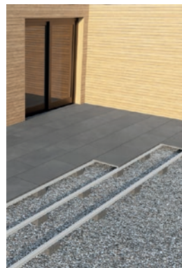
Verlegung auf Terrassen- Unterkonstruktion
