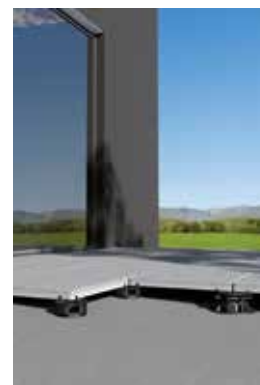
pokládka dlažby na terče
