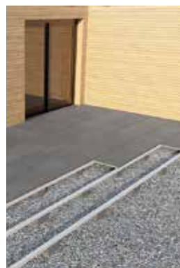
pokládka na nosnú konštrukciu
