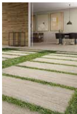
pokládka dlažby do trávy
