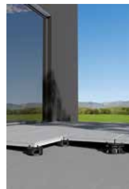
pokládka dlažby na terče
